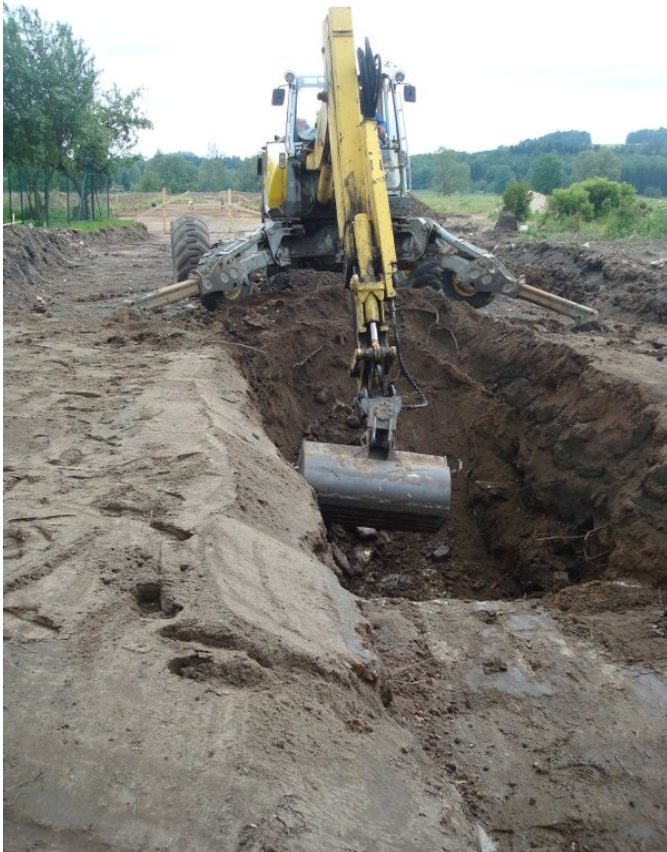
Hloubení zeminy z bývalého kanálu
